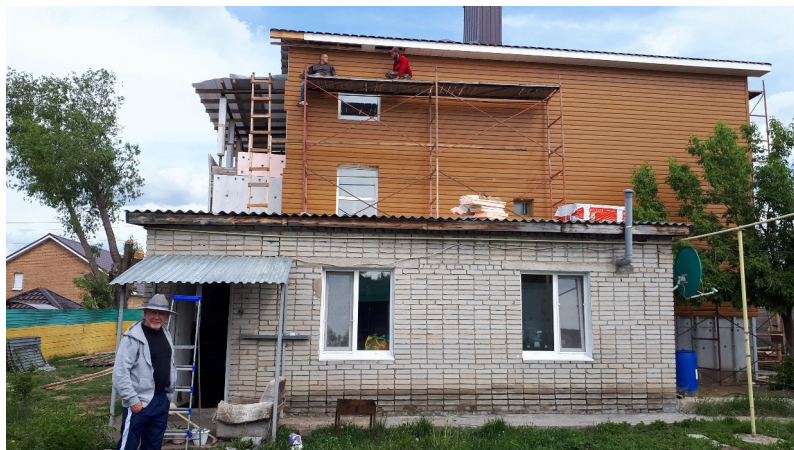
Капитальный ремонт и утепление церковного дома в Костанайе (2019 год)
